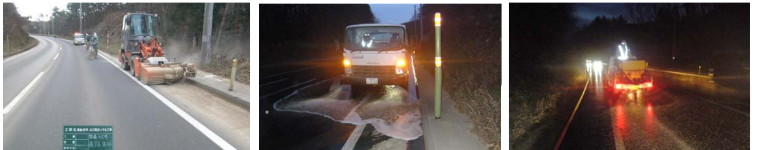
④細かい砂は大きな回転ブラシで掃除します。⑤埃(ほこり)を散水車で洗い流します。⑥洗った水が凍らないよう融雪剤をまきます。
