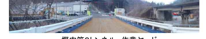
桜内第2トンネル 作業ヤード
