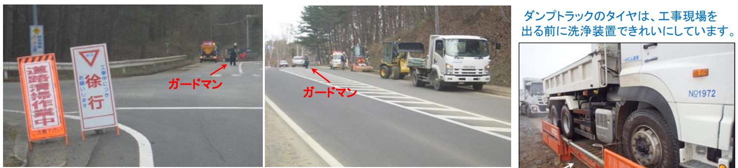
看板を設置し、清掃中であることをお知らせします。交通誘導するガードマンもいます。清掃は、誰が何をどの様にやるのか、きちんと決めてから行っています。私たちの仕事は野球やサッカーなどと同じ、チームプレーが重要なのです。
