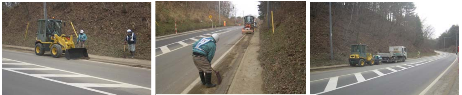
①ショベルカーで溜まった泥をすくい取ります。②細かい泥はスコップを使って取り除きます。③取り除いた泥はダンプトラックに積み込みます。
