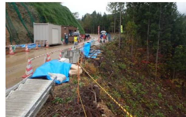
現場内の整理整頓状況を確認
