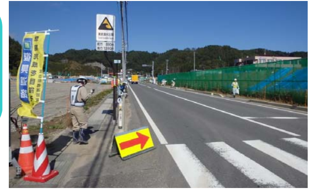
田老荒谷地区の国道45号沿いで行いました。
