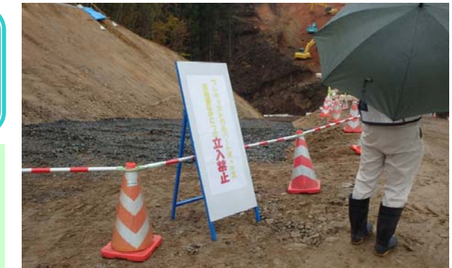
通路確保や立入禁止看板設置も安全管理上必要なものです。
