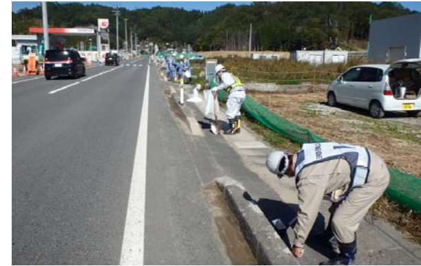
沿道のごみ拾いと路肩の土砂の除去を行いました。
