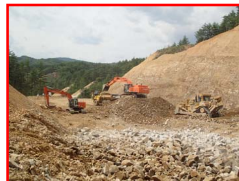
▲ 道路掘削作業状況
