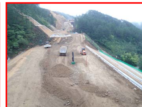
▲ 道路盛土作業状況
