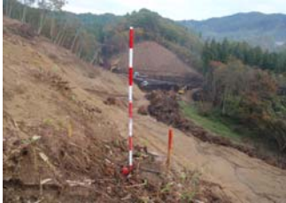
▲ 起点側より全景
