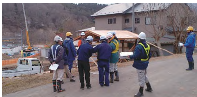
▲関係機関協議の様子（立会）
