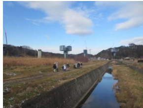
橋の全景を眺めながら移動
