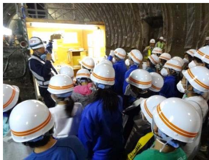
トンネル坑内見学の様子
