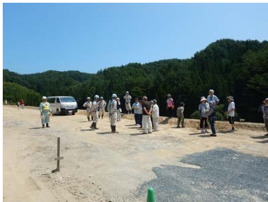
盛土区間の見学
