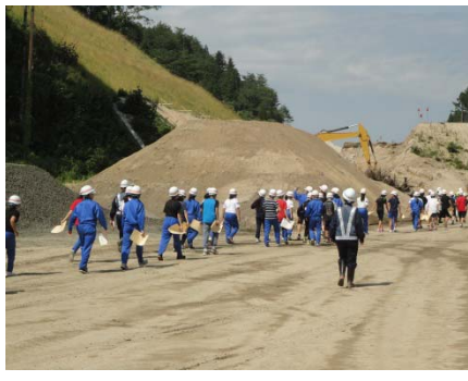
◆工事現場を見学する児童
