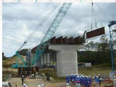
架設状況を見学
