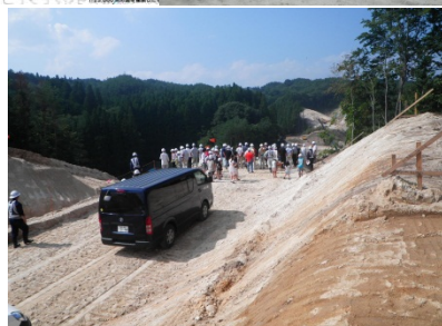
盛土状況を見学。
