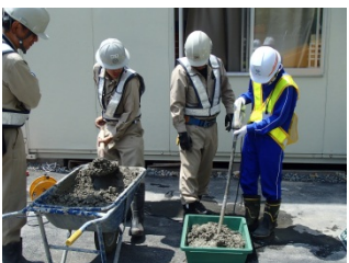
コンクリートの打設。
