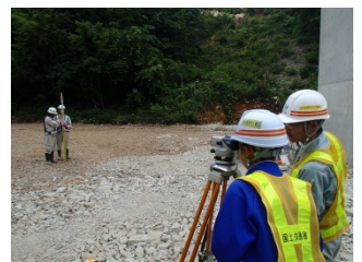
レベルを用いての測量。
