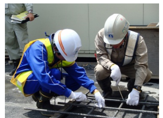
鉄筋の組立作業。
