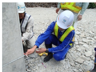
橋脚の幅・長さなどを測定。
