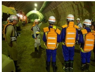
樫内第2トンネルを見学。
