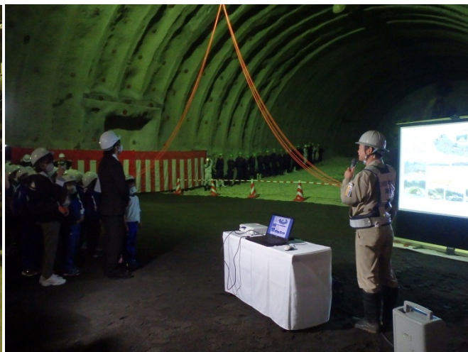
▲切羽付近でトンネルについての説明
