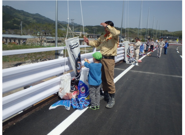
▲園児と工事施工者で揚げる準備
