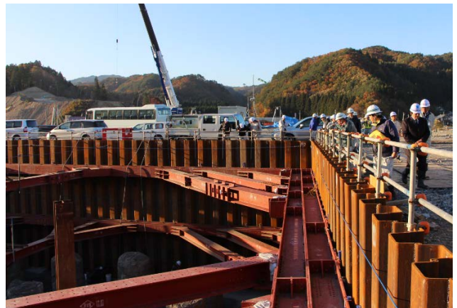
▲（仮称）新小本大橋の下部工工事現場にて
