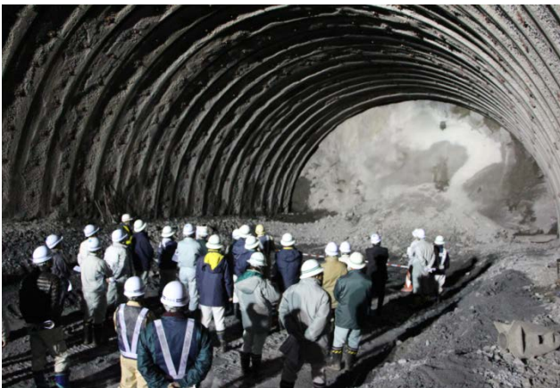
▲（仮称）小本トンネル（1,134m） 掘削最深部 約300m地点で工事説明
