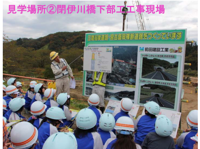
▲担当者が橋脚の下にある50mの基礎杭が見えない所で橋を支えていることを説明
