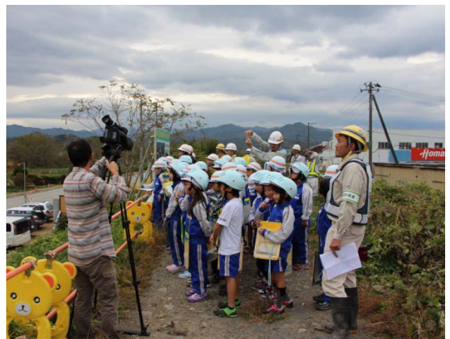
▲大型クレーンによる作業を間近で見てもみんな興奮していました！
