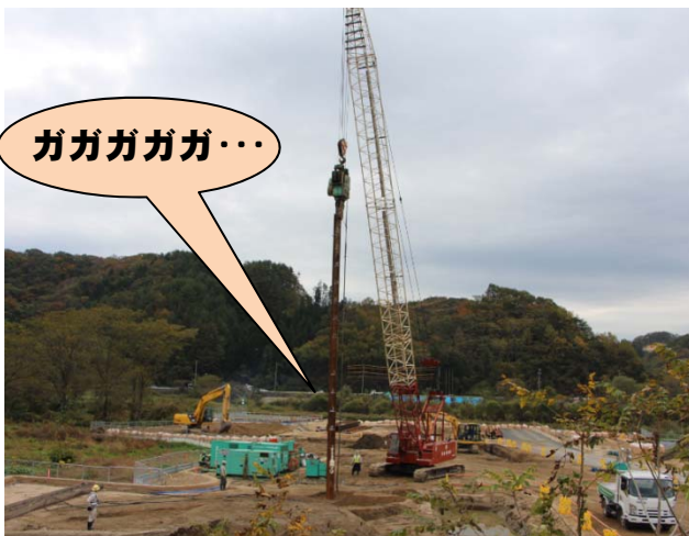
▲実際の地中への打ち込み作業を見学しました
