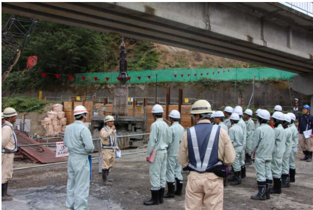
▲復興道路の工事現場を間近で見学! 新小本大橋の下部工工事現場にて
