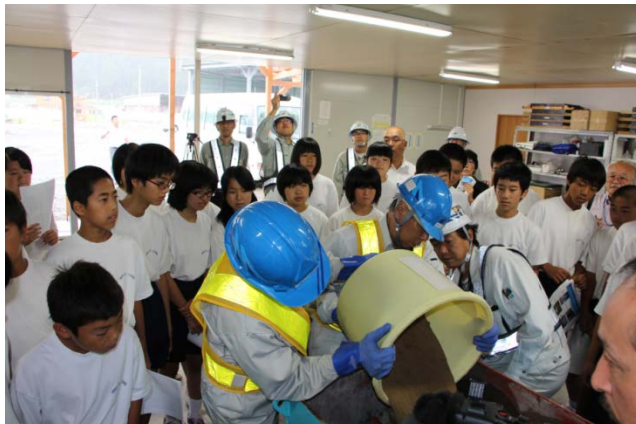
▲セメントや砂利などを混ぜて生コンクリートができる様子を間近で見学
