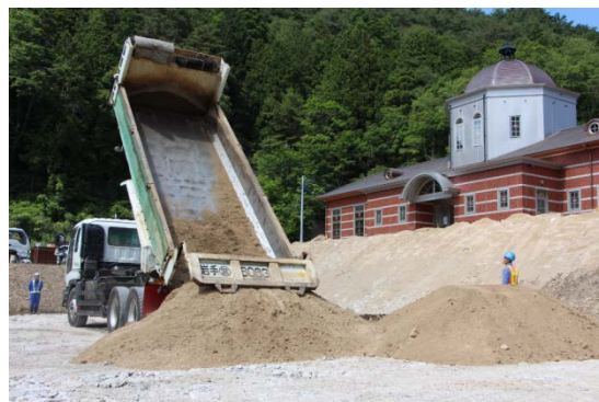
▲トラックで土砂を搬入する様子 駅舎と同じ海拔14.5mにかさ上げします
