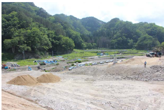
▲田野畑村で整備中の島越駅前広場整備事業現場（駅舎付近から撮影）
