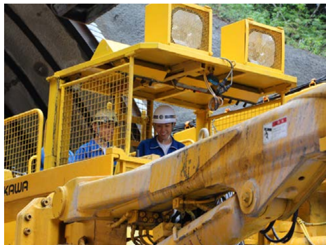
▲トンネルを掘削する大型機械に試乗 みんなとっても喜んでいました！
