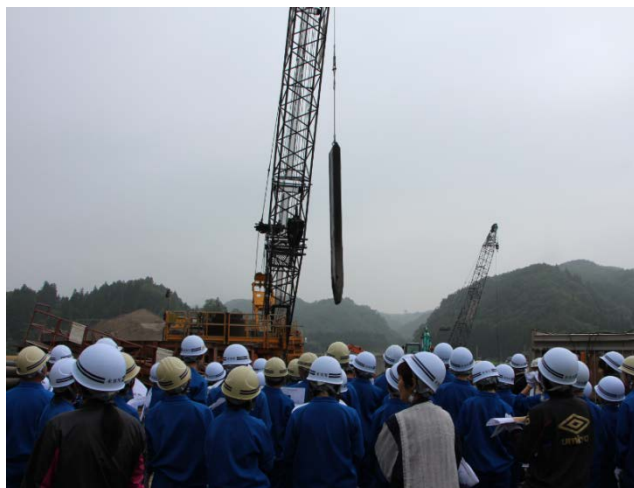
▲橋の基礎杭を打ち込むためにクレーンで地下の岩盤を砕く作業を間近に見て興奮！
