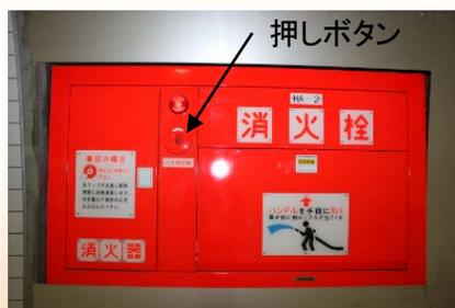
▲消火栓、消火器、押しボタン式通報装置(約50mおき)
