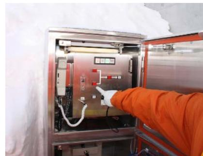
▲鎮火後、ジェットファンによるトンネル内の排煙操作を実施
