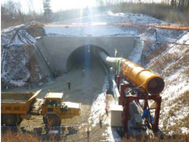
▲田老第6トンネルの北側坑口 ここから掘り始めました
