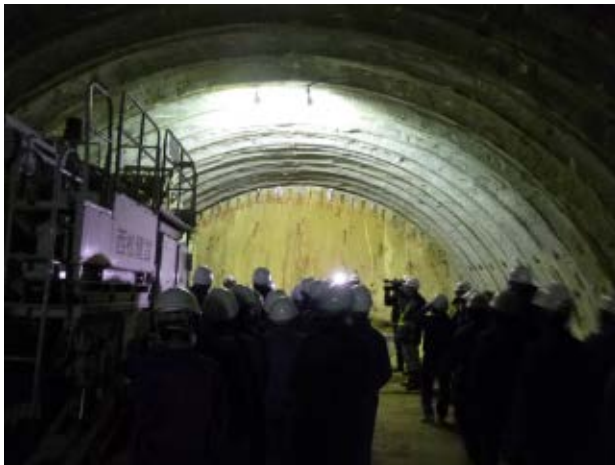
▲現地点でのトンネル掘削最先端 <255m>地点 残り39mです
