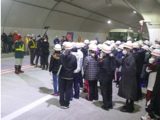
▲三陸国道事務所 岩瀨建設監督官がトンネルの概要や作業について説明
