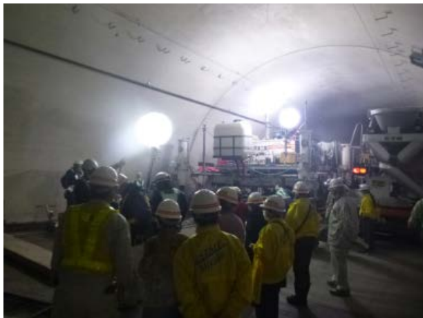
▲尾肝要道路工事現場を間近で見学
