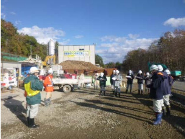
▲小滝建設監督官が工事概要を説明
