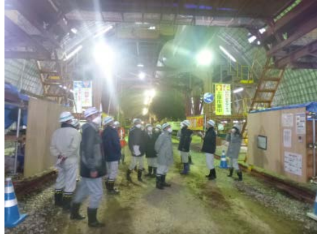
▲トンネル工事現場を間近で見学
