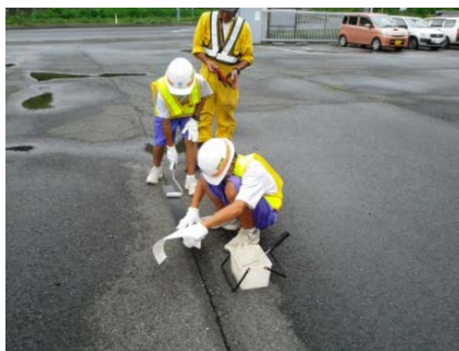
▲路面のヒビ割れを補修。 上手にできました。
