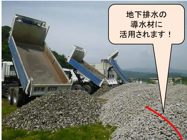
▲分別再生砕石の搬出作業の様子
