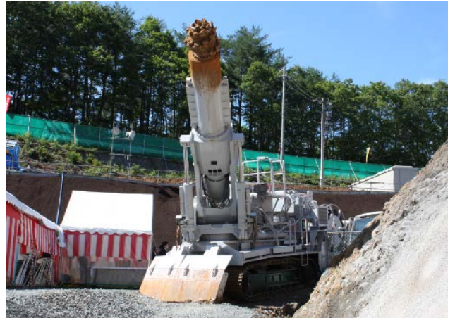
▲トンネル掘削時は、このブームヘッダーという大きな機械が活躍します
