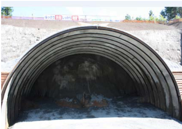
▲田老第6トンネル終点側（北側）坑口 いよいよ本格的に掘削工事が始まります
