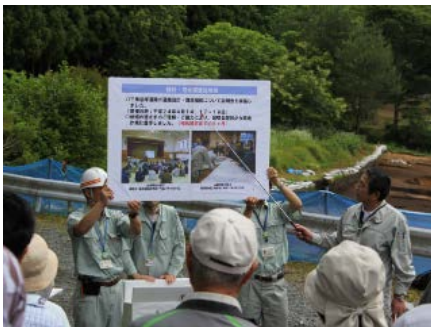
▲三陸国道事務所 戸嶋守副所長が三陸沿岸道路の工事概要を説明。
