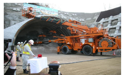
ドリルジャンボによる重機稼働
