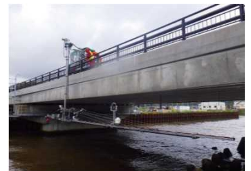
点検支援技術による橋梁点検
