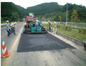
▲舗装修繕の様子
