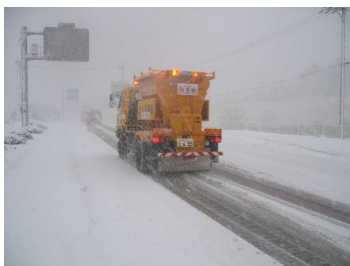
▲除雪（凍結抑制剤散布）の様子
