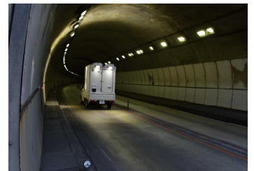
点検支援技術によるトンネル点検
