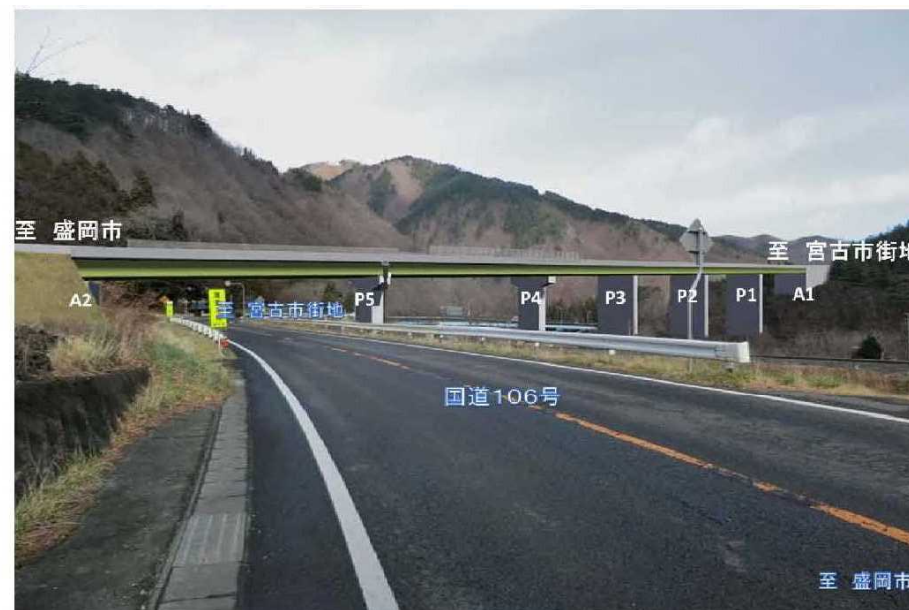
【施工箇所写真】
