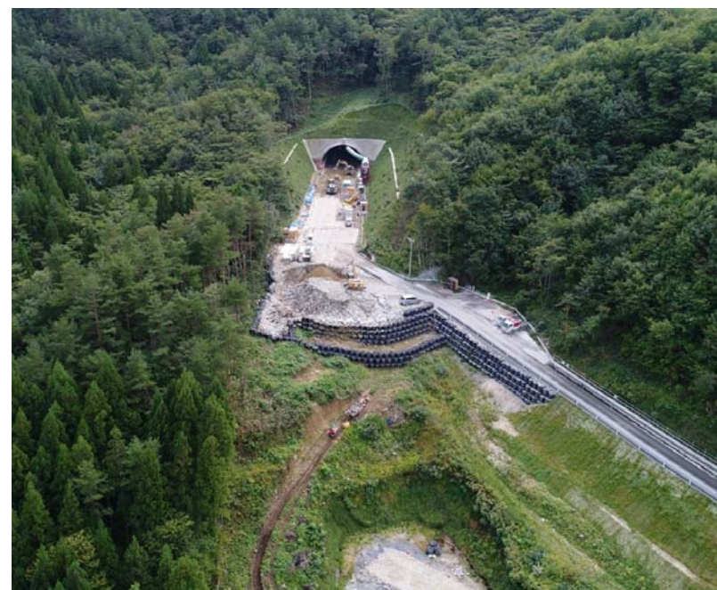
トンネル坑口写真 (普代村側)
