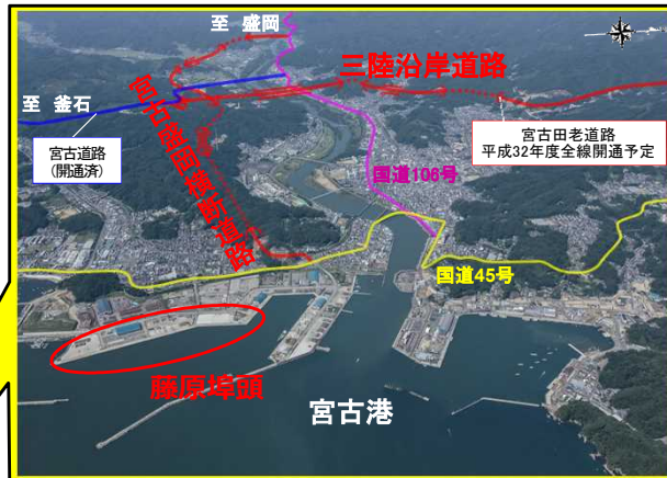
▼宮古港周辺の道路整備状況
