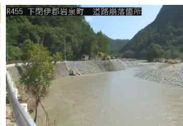
▲国道455号 乙茂 監視状況
