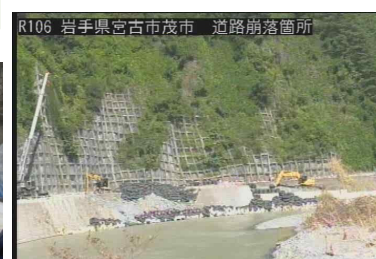
▲国道106号 茂市 監視状況
