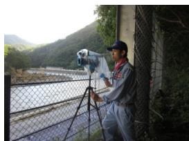
▲国道106号 茂市 カメラ調整中
