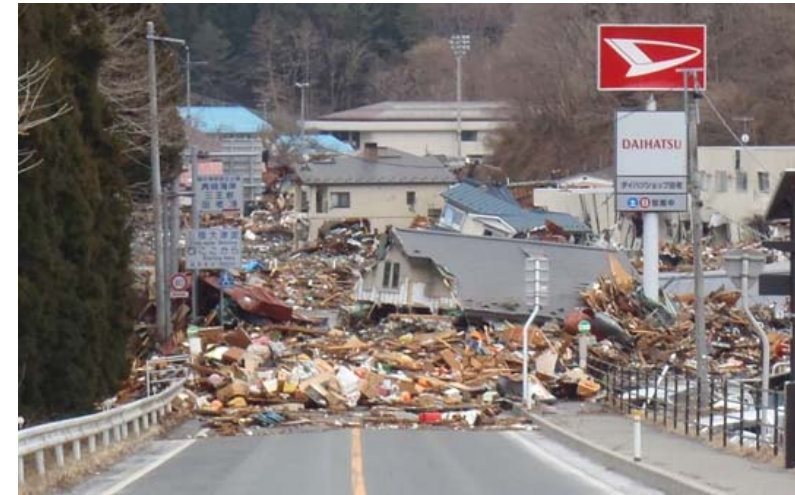
写真① 宮古市田老地区
