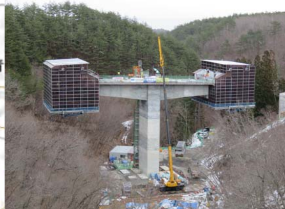
(仮称) 青の滝川橋 工事状況 張出架設中の橋梁の上部工について、 橋上(約30m上空)から 見学していただく予定です。
