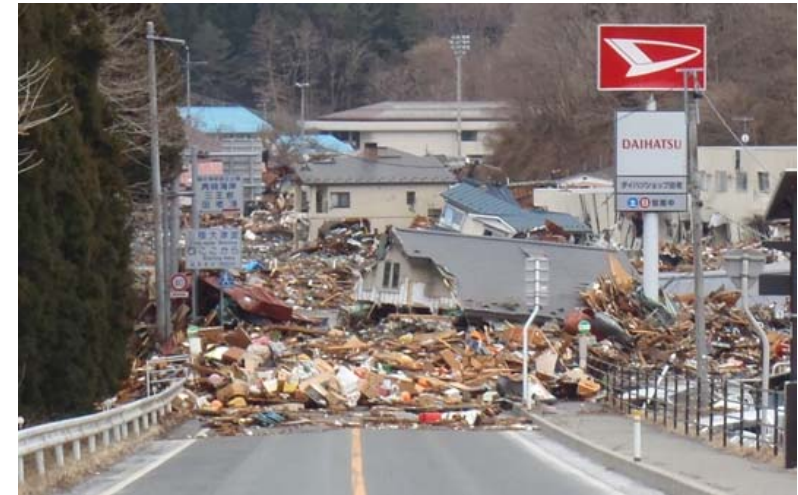
写真① 宮古市田老地区
