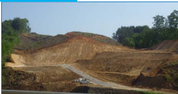
着手前 (切土区間)
