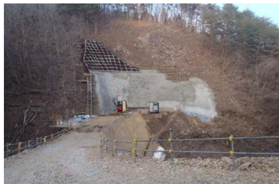
▲宮古側トンネル坑口状況
