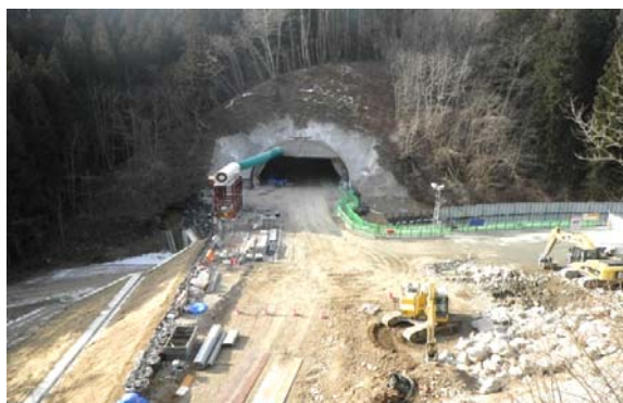
▲田老側トンネル坑口状況
