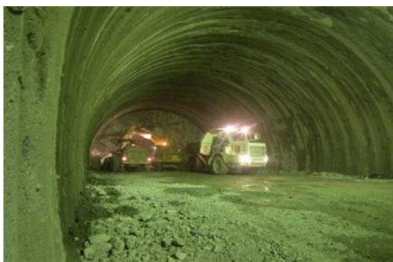
▲トンネル内 作業状況
