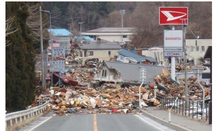
写真① 宮古市田老地区
