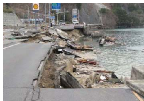
▲国道45号の路面崩壊状況(東日本大震災時)
