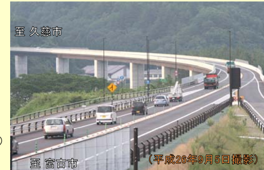
▲ 普代道路の通行状況
