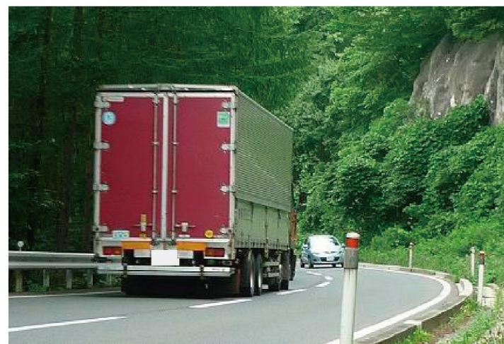
▲線形不良箇所
