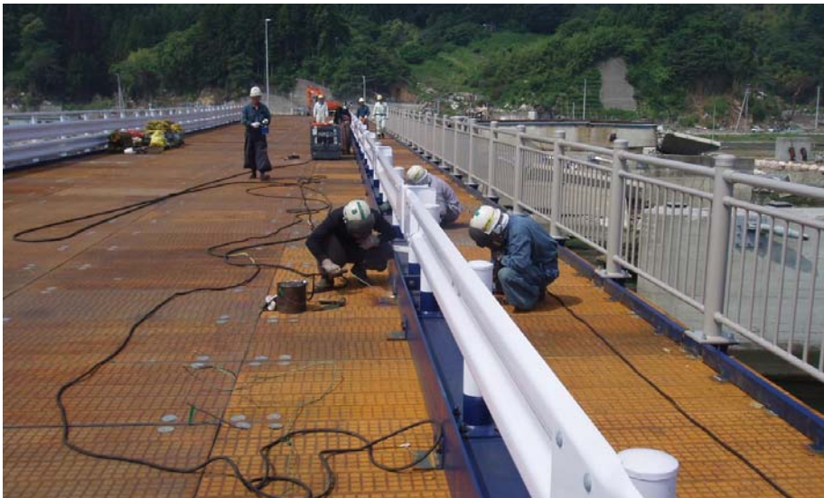
▲施工状況【補車道分離防護柵設置】 左岸側から右岸側を望む
