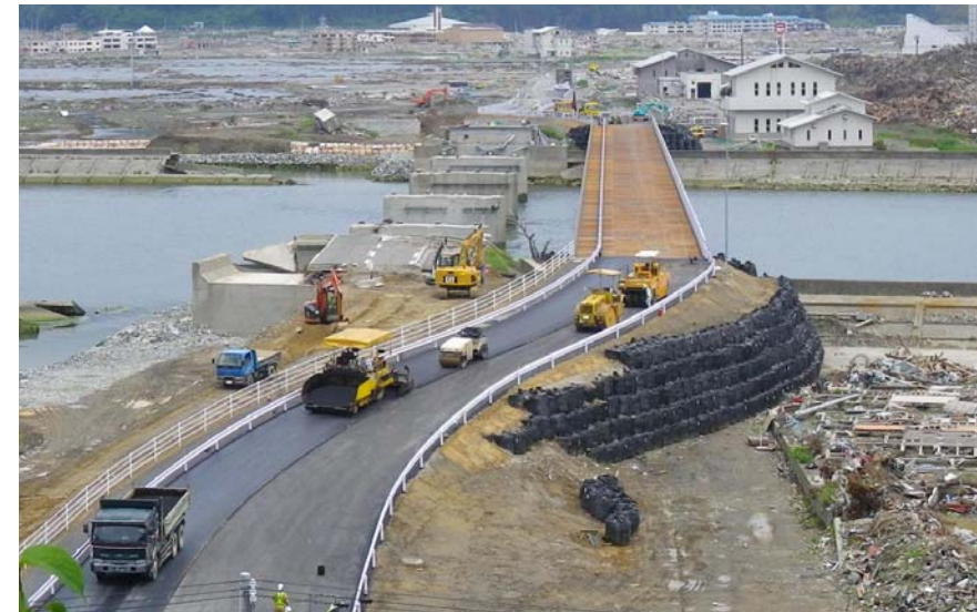
▲施工状況【仮橋前後車道舗装】右岸側から左岸側を望む
