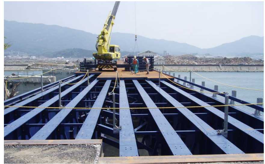
▲施工状況【覆工板設置】右岸側から左岸側を望む
