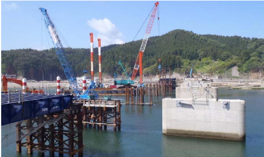
▲施工状況【下部工打設・上部工架設】 左岸側から右岸側を望む
