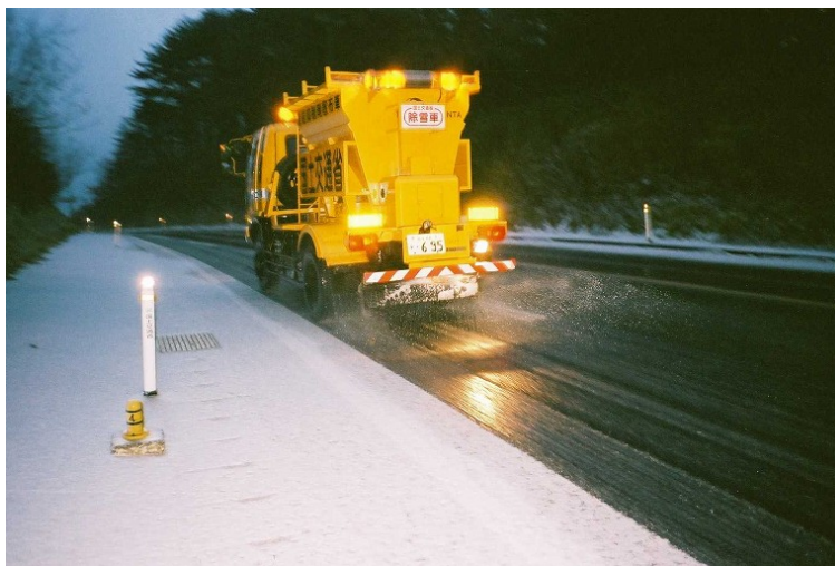
散布作業状況 (気温の変化に応じて散布量を低減します)
