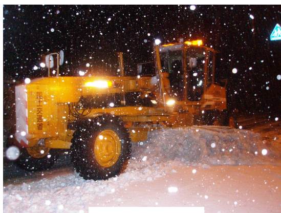
車道の除雪状況
