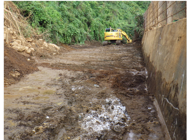
⑥令和6年8月7日(水)_応急復旧完了
