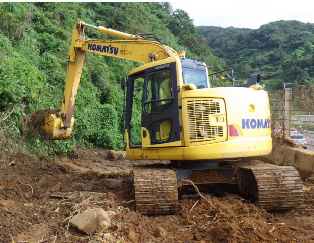
崩落土砂撤去作業
