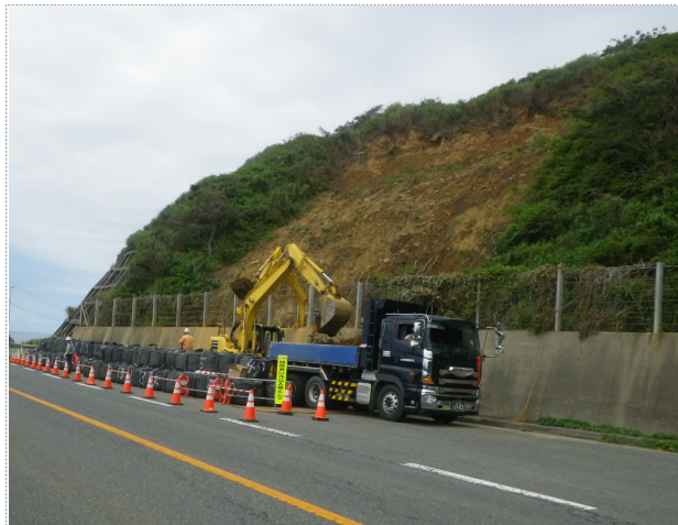
崩落土砂撤去運搬作業
