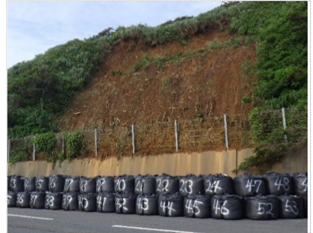
大型土のう設置によるポケット(土砂止め)の確保
