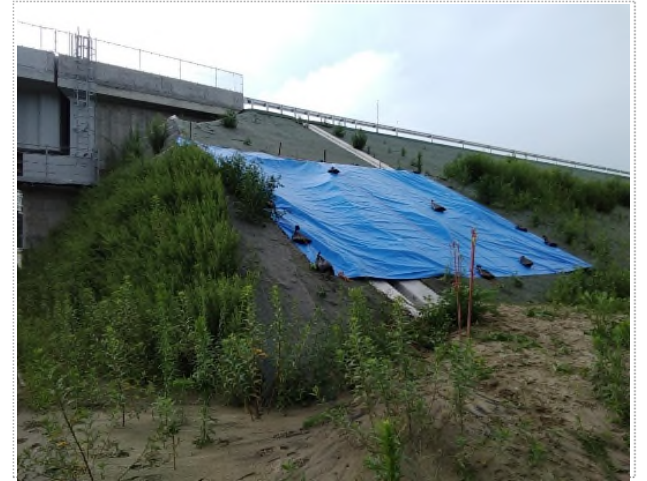
ブルーシートによる養生
