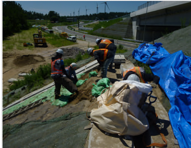
植生土のう設置作業
