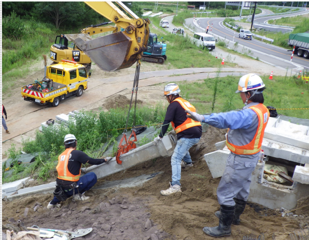
側溝設置作業
