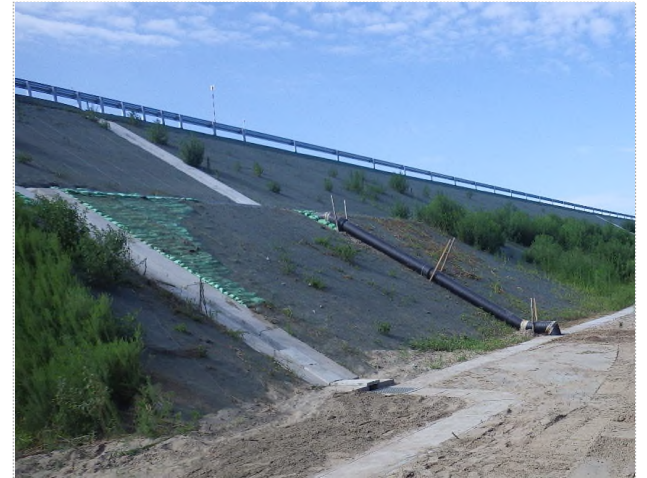
⑥令和6年8月4日(日)_応急復旧完了
