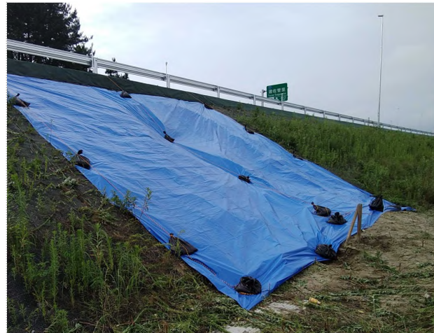
ブルーシートによる養生
