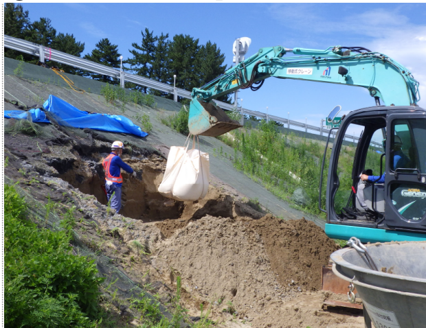
大型土のうの設置作業
