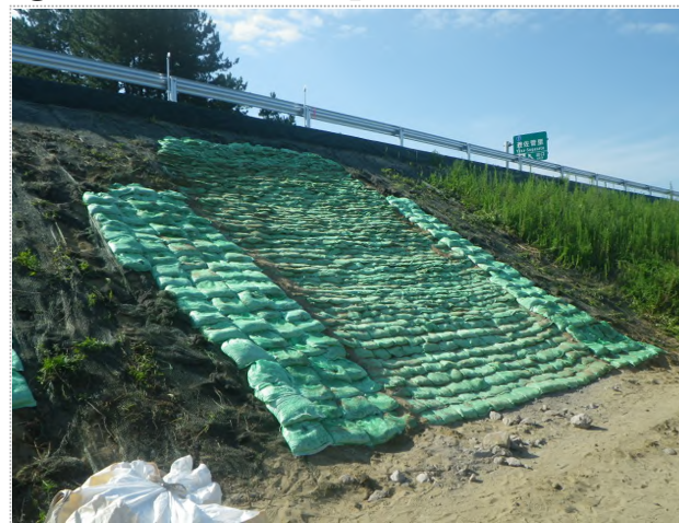
⑥令和6年8月4日(日)_応急復旧完了
