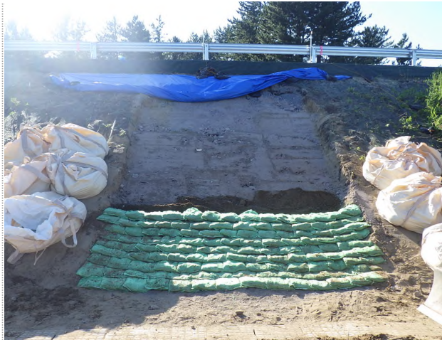
盛土作業完了、植生土のう設置作業
