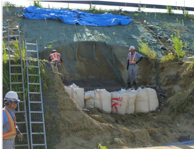
大型土のうの設置作業
