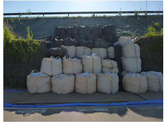
⑥令和6年8月8日(木)_応急復旧完了
