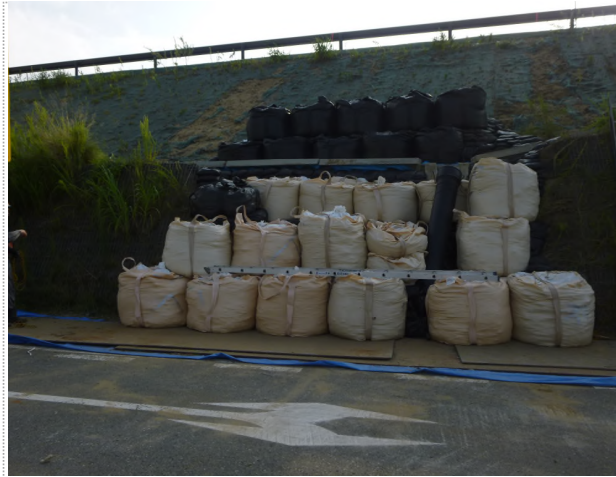
土のう設置、盛土、小段排水仮設置
