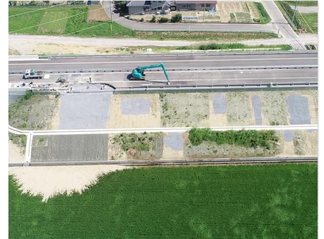
応急復旧\_光ケーブル設置、排水構造物設置
