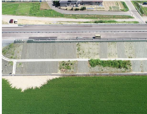
応急復旧\_ガードレール設置、法面シート設置
