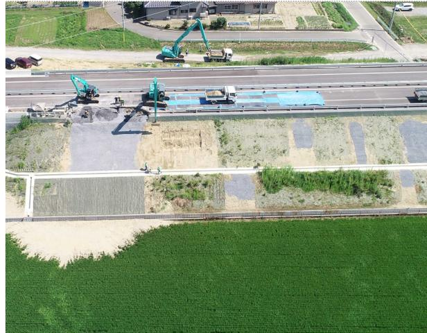
応急復旧\_路肩崩落の盛土作業、排水構造物設置
