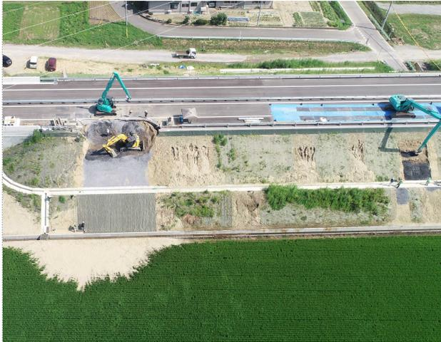
応急復旧\_路肩崩落の盛土作業、法面復旧
