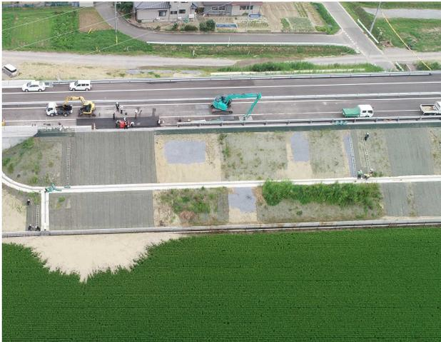
応急復旧\_路肩崩落部の舗装、法面シート設置
