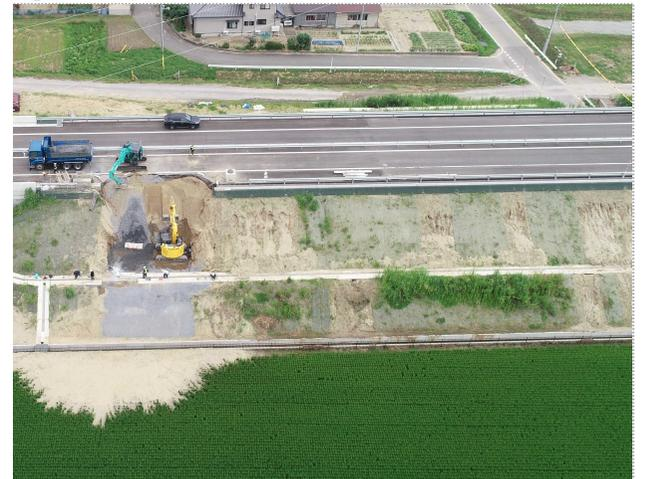
応急復旧 路肩崩落の盛土作業、排水構造物設置
